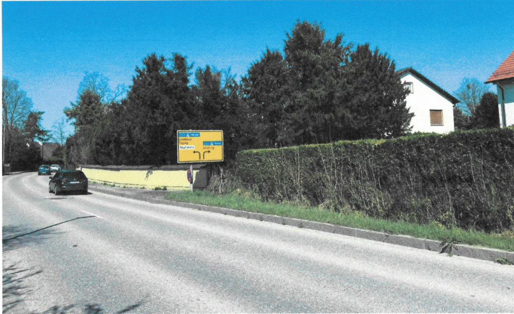
Abbildung 8: Foto vom mittleren Bereich, 03.04.2025, Gehweg unterbrochen
